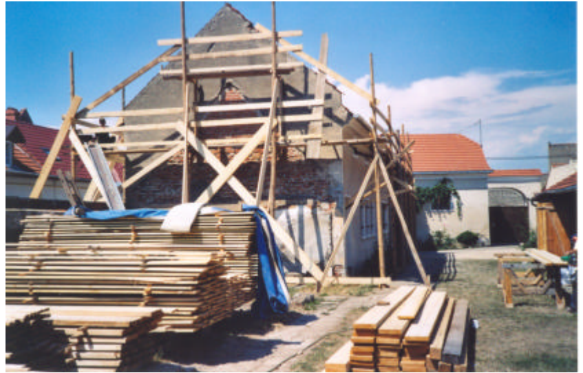
Neues Dach für die Casa Livezii
