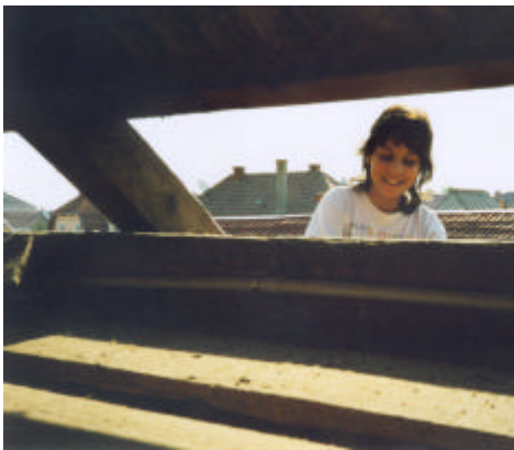
Lidiana auf dem Dach am Arbeiten
