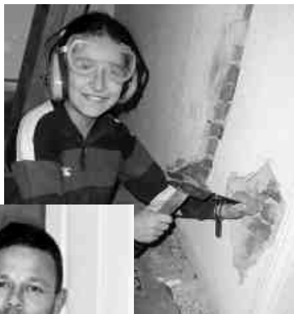
Auch Georgiana (12) gefällt es, auf der Baustelle zu arbeiten
